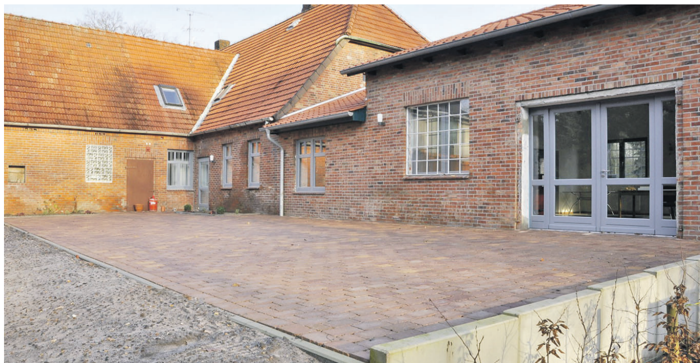
Hinter dem renovierten Gebäude, das unter anderem komplett entkernt wurde, befindet sich eine großzügige Terrasse .
